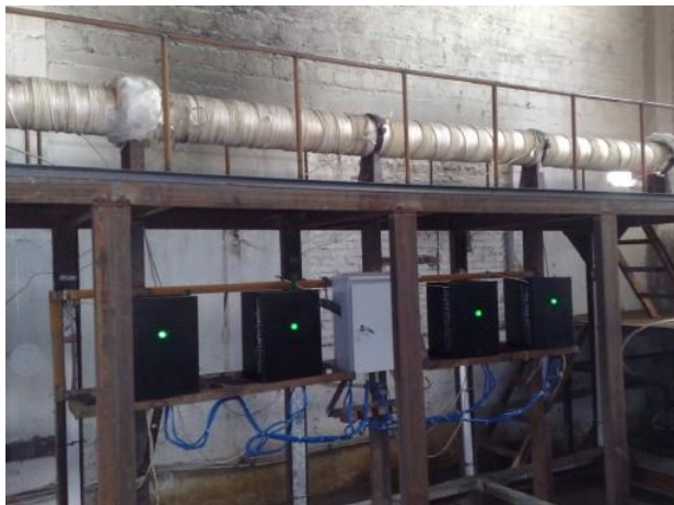
多个 20KW 在 500℃ 石蜡加热中应用
